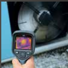
检测暖通空调系统异常
